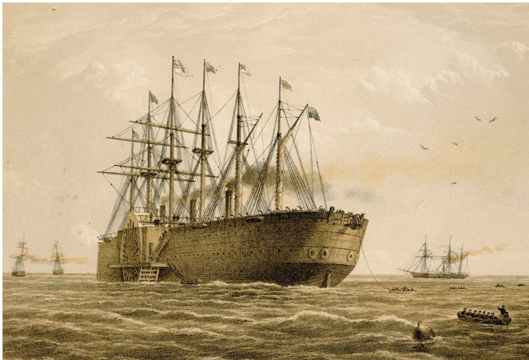
大东方号在大西洋中铺设电缆
